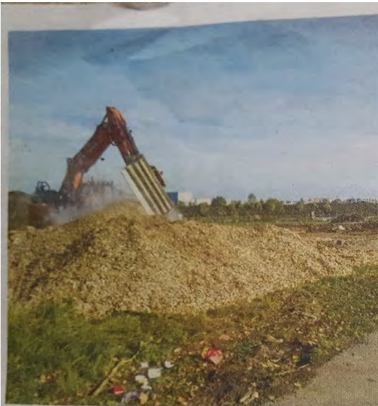
De eerste werkzaamheden voor de bouw van de Dordtse 'asowoningen' zijn begonnen.
